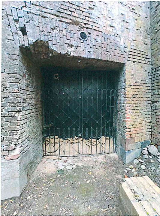
Fot. 6,7. Brama 2 zabezpieczona od zewnątrz workami z piaskiem przeciw przepływającej wodzie, wewnątrz bramy z drewnianą framugą.
