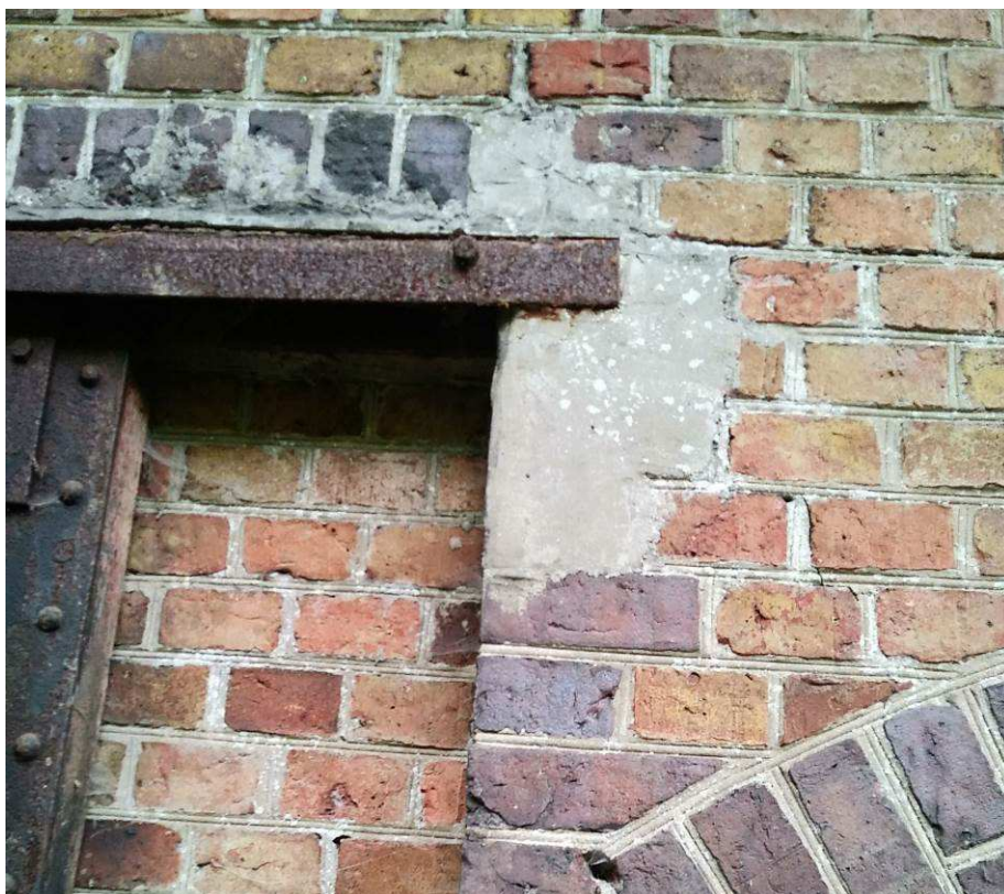
Fot. 3 osadzenie przewodnicy górnej z wyraźnymi wtórnymi zabezpieczeniami w postaci betonowej masy; nad przewodnicą widoczne ubytki w wątku ceglany nadproża
