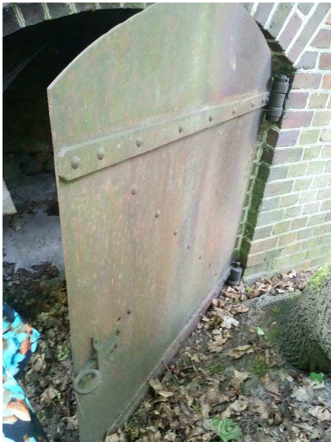
Fot 12. Okienica do magazynu podręcznego lewego; klapa zablokowana przez osuwisko ziemi, widoczna silna korozja materiału
