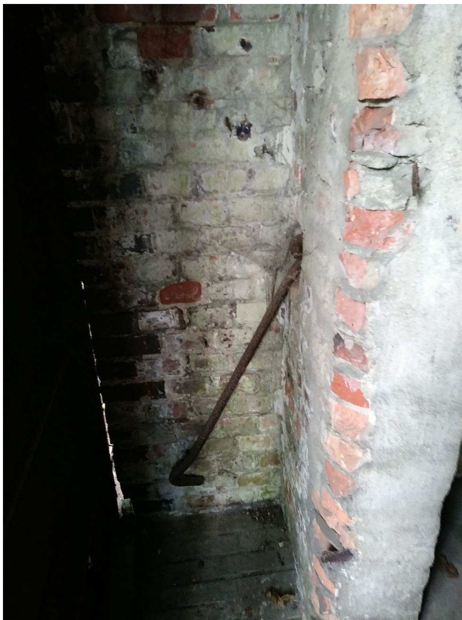
Fot. 7 Hak blokujący – mocowanie do ściany obiektu; widoczna silna korozja materiału
