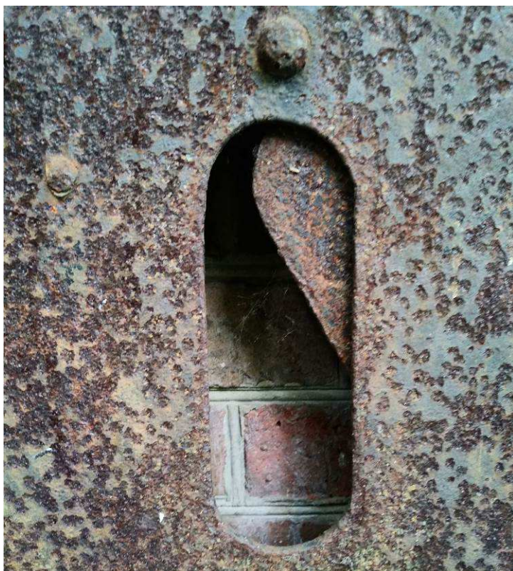
Fot.5 Otwór w bramie przesuwnej, wizjer. Widoczny fragment klapki przysłaniającej; widoczne wyraźne równomierne skorodowanie materiału; kolor oryginalny feldgrau.
