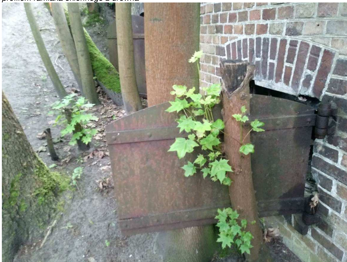
Fot. 9. Okiennica stalowa widok zewnętrzny zachowana w dobrym stanie, Widoczna silna korozja materiału; okiennica blokowana przez przerośnięte drzewa
