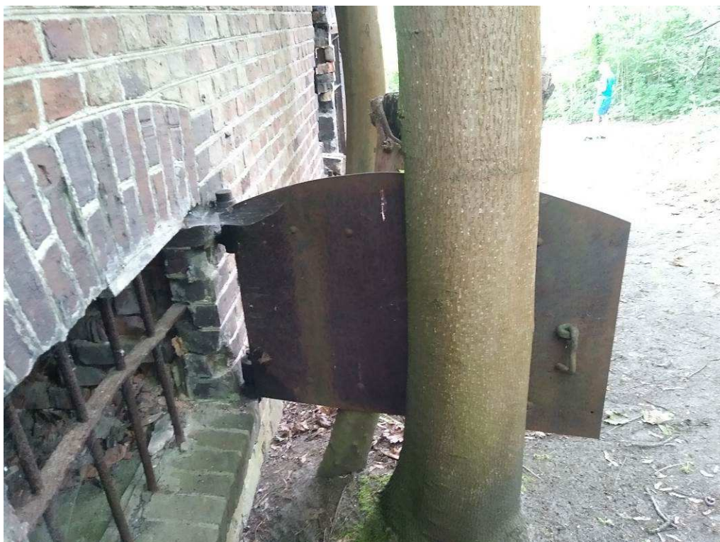
Fot. 10 Zachowana okiennica i kraty w oknie magazynu; widoczne silne ślady korozji; kłapa zablokowana przez przerośnięte drzewa.
