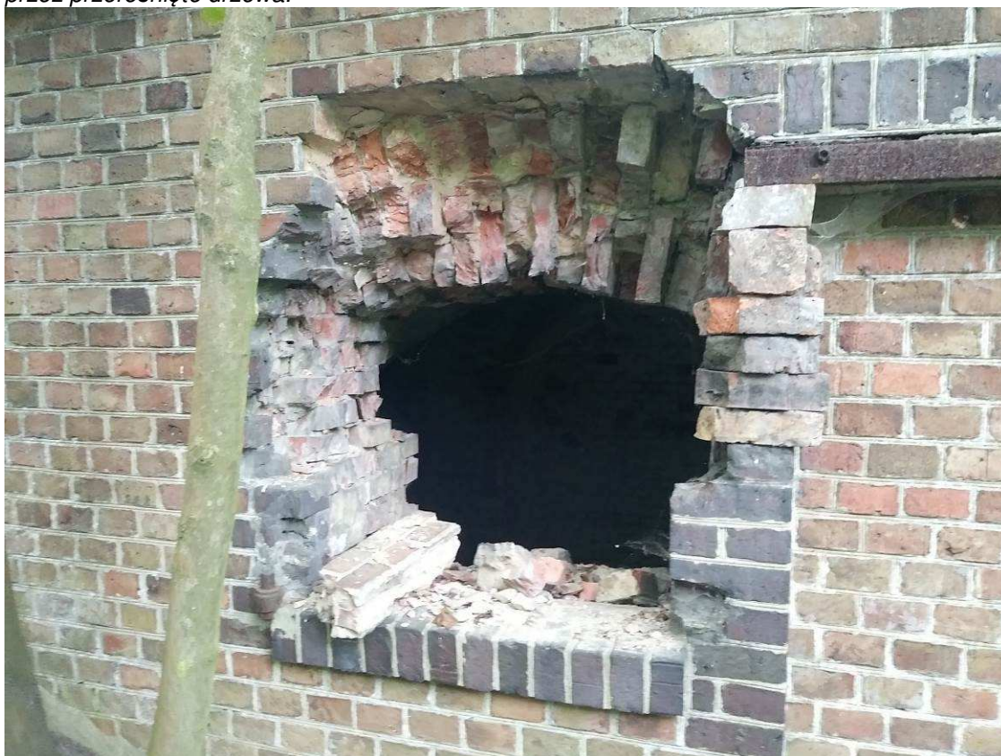
Fot 11. Zniszczone okno do magazynu, widoczne uszkodzenie wątków ceglanych przez wyrwaną kratę. Brak wierzchniej warstwy w wątku elewacji. Widoczne pozostałości kotw okiennicy stalowej po lewej stronie
