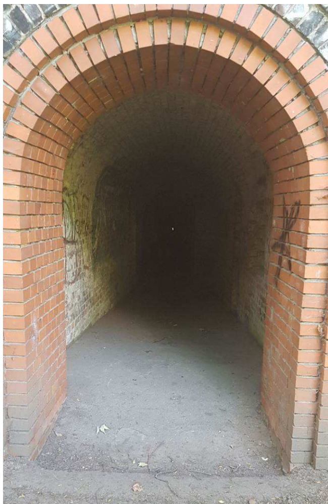
Fot 16. Wejście do kaponiery barkowej lewej. Cegły wtórnie uzupełnione w wyraźnie jaśniejszym odcieniu. Pozostała część wątku wokół okna w odcieniu ciemniejszej cegły (brązowy); brak drzwi wejściowych.
