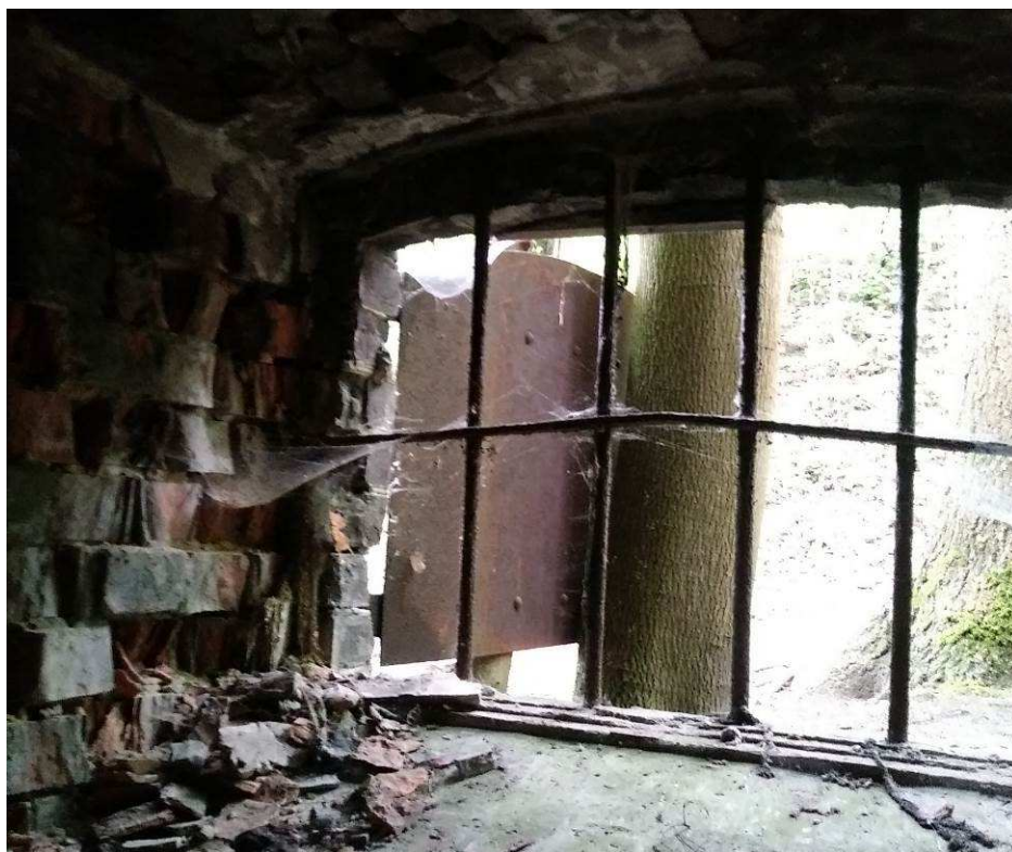
Fot 8 Widok od wewnętrznej strony okna z uszkodzeniami wątków ceglanych i szczątkowo zachowanym profilem ramiaka okiennego z drewna
