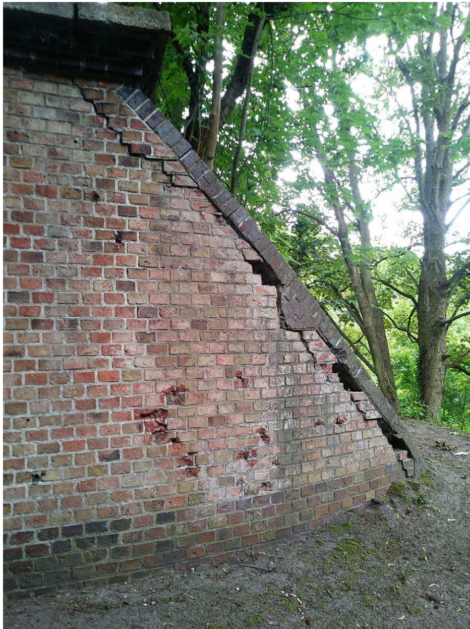
Fot. 15 Uszkodzenie wątku ceglanego i odspojenie detalu grożące penetracją czynników destrukcyjnych jak woda opadowa, mróz etc. Widoczne
