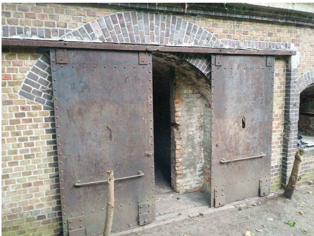
Fot. 2 Drzwi przesuwne do magazynu, wyraźne ślady przemałowań i skorodowania wierzchniej warstwy
