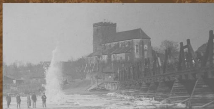
Drewniany most na Warcie w Pyzdrach. W tle widoczny wybuch miny założonej przez saperów w celu zlikwidowania zatoru lodowego na rzece. Pyzdry, rok 1929. (NAC)
