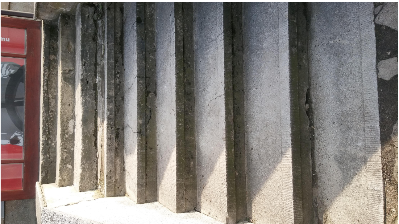
Fot.5 – Schody zewnętrzne z elementów betonowych i lastriko
